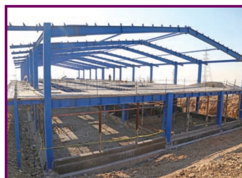
▲ نصب اسکلت فلزی ساختمان کنترل
