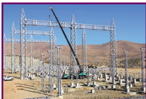
▲ نصب سازه‌های تجهیزات بخش ۴۰۰ کیلوولت
