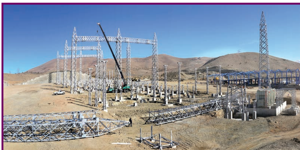
▲ نمای کلی پروژه احداث پست برق باغستان
