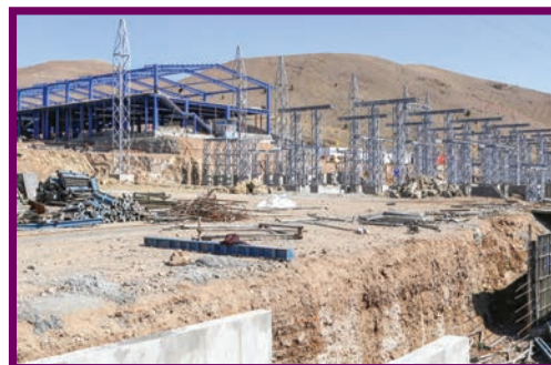
▲ کانال و اسکلت فلزی تجهیزات بخش ۶۳ و سازه‌های ساختمان کنترل
