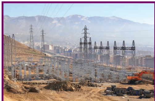
▲ نصب سازه‌های تجهیزات بخش ۶۳ کیلوولت
