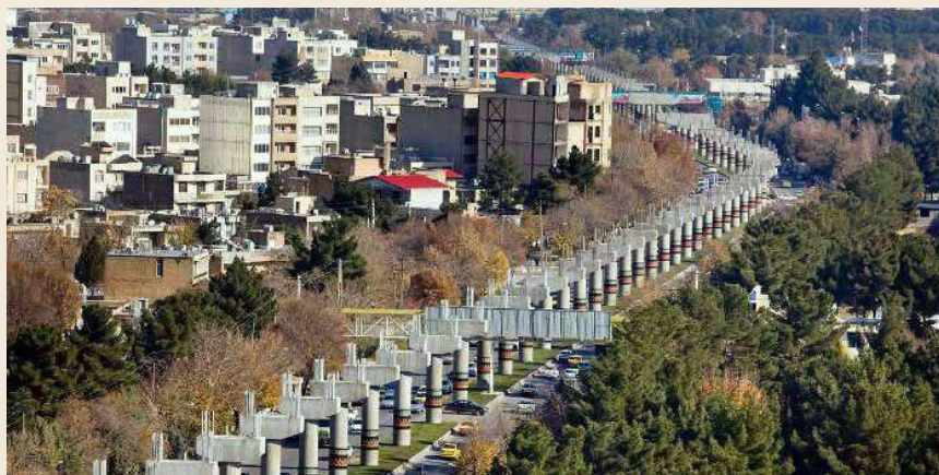
نمایی از احداث عرشه
