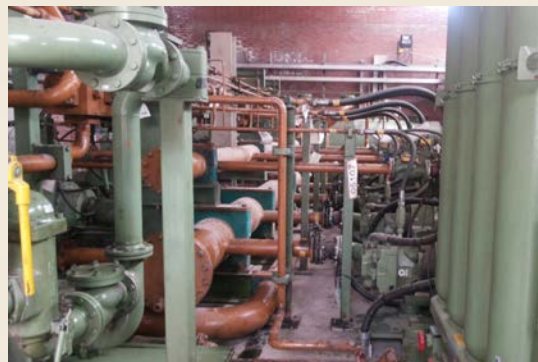
اعلام و اطفای حریق ترانس‌های قدرت پست ۴۰۰ کیلو ولت فولاد مبارکه
