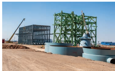
پروژه احداث کارخانه احیا اردکان
