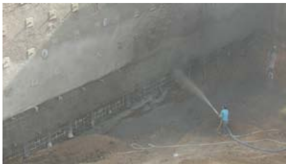
اجرای شات کریت دیوار پس نصب مش و ژئوکامپوزیت
