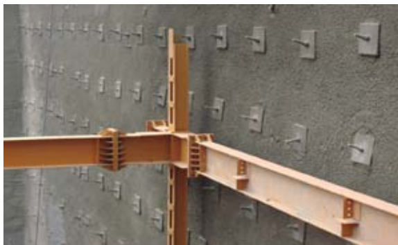
دیواره سازه نگهبان اجرا شده به روش نیلینگ سطح تمام شده شات کریت
